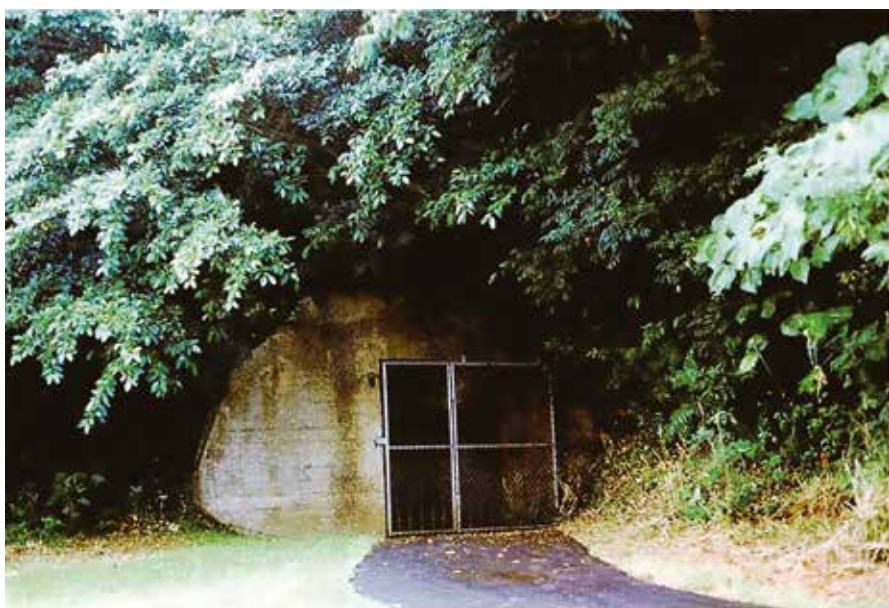
コンクリートで建造された砲台跡
